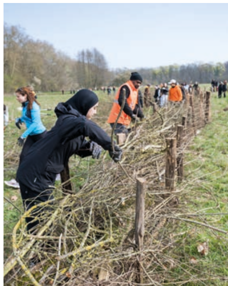
Le bois utilisé pour construire cette structure de 400 mètres de long est issu de coupes menées dans les réserves. ©P. STIRNWEISS
