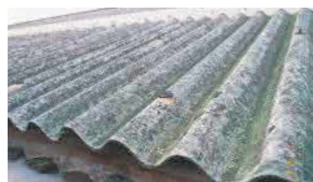
Toiture en amiante-ciment
