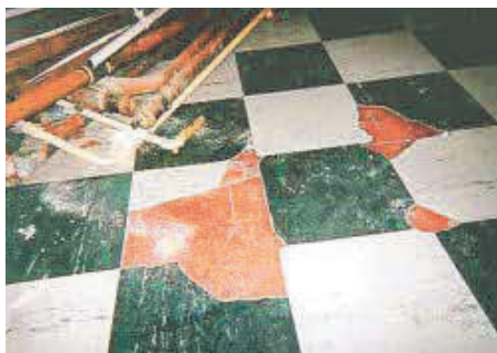
Dalles de sol
