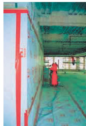
Chantier de désamiantage
