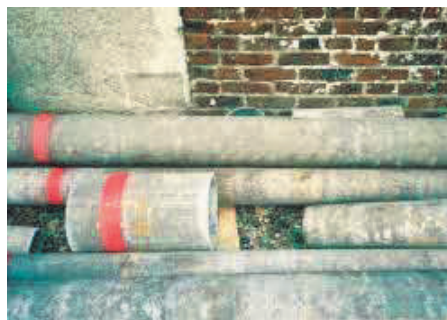
Canalisation en amiante-ciment
